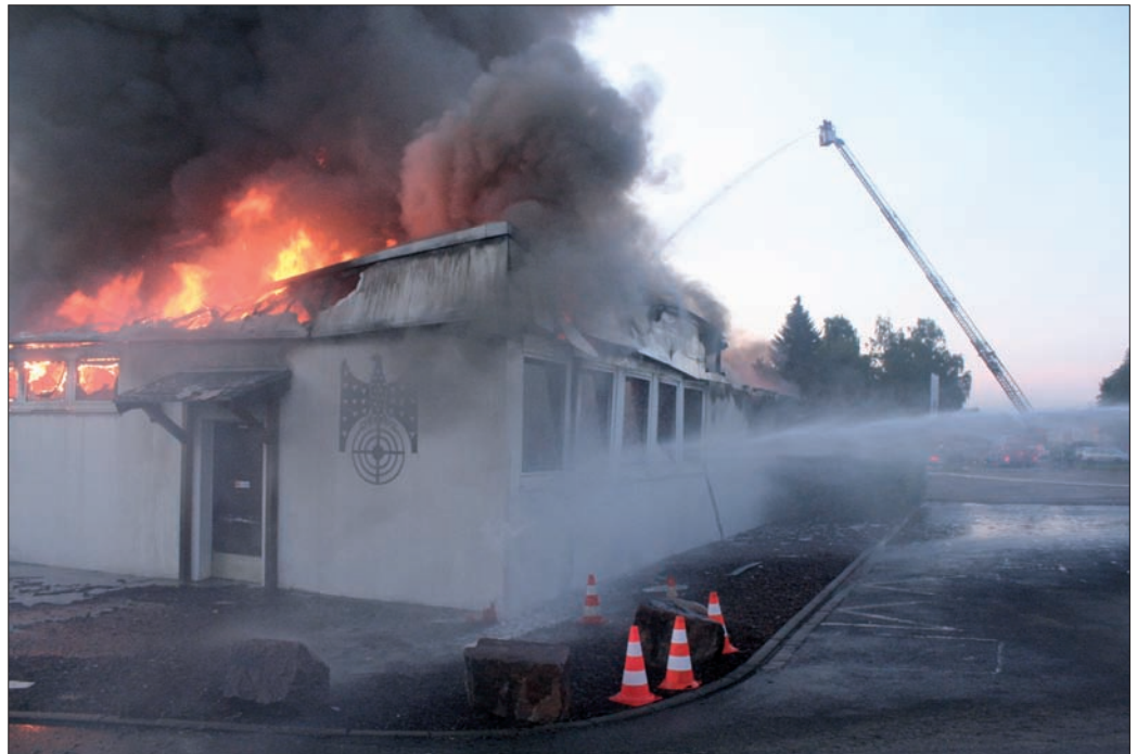
Am 4. Juni brannte das Schützenhaus in Föhrste bis auf die Grundmauern nieder.
