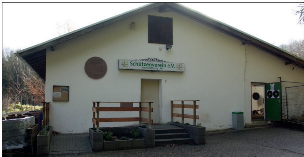
Das Schützenhaus des SV Wilgersdorf mit in Eigenregie gebauter Rampe.
